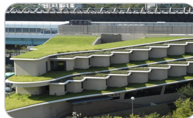
芝生による屋上緑化の事例
