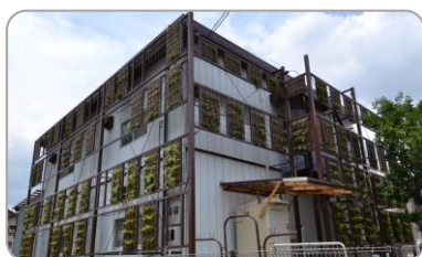
基盤造成型の壁面緑化の事例
