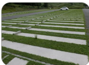
車輪部を補強している事例
